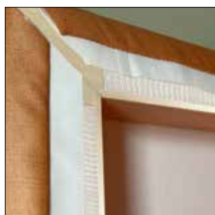
F Fissaggio del telo al telaio con il velcro in angolo
